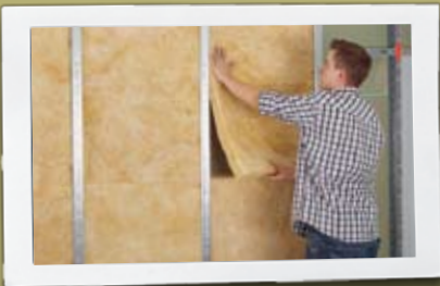
_ Mineralwolle eignet sich auch für Leichtbauwände und als Vorsatzschale für Innenwände.
