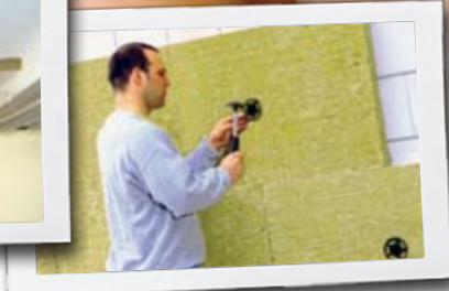
_ Anbringen eines Wärmedämmverbundsystems
