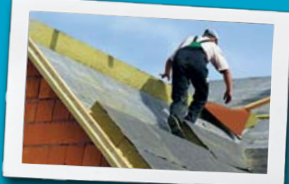
_ Einbau Aufsparrendämmung
