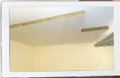
_ Anbringen von Mineralwolle-Dämmplatten an der Kellerdecke
