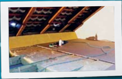
_ Dämmen der obersten Geschossdecke
