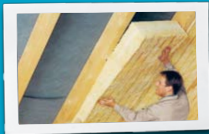
_ Einbau Zwischensparrendämmung
